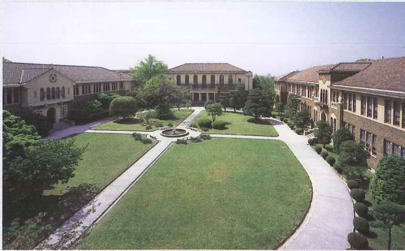
総務館より文学館・図書館本館・理学館を望む
